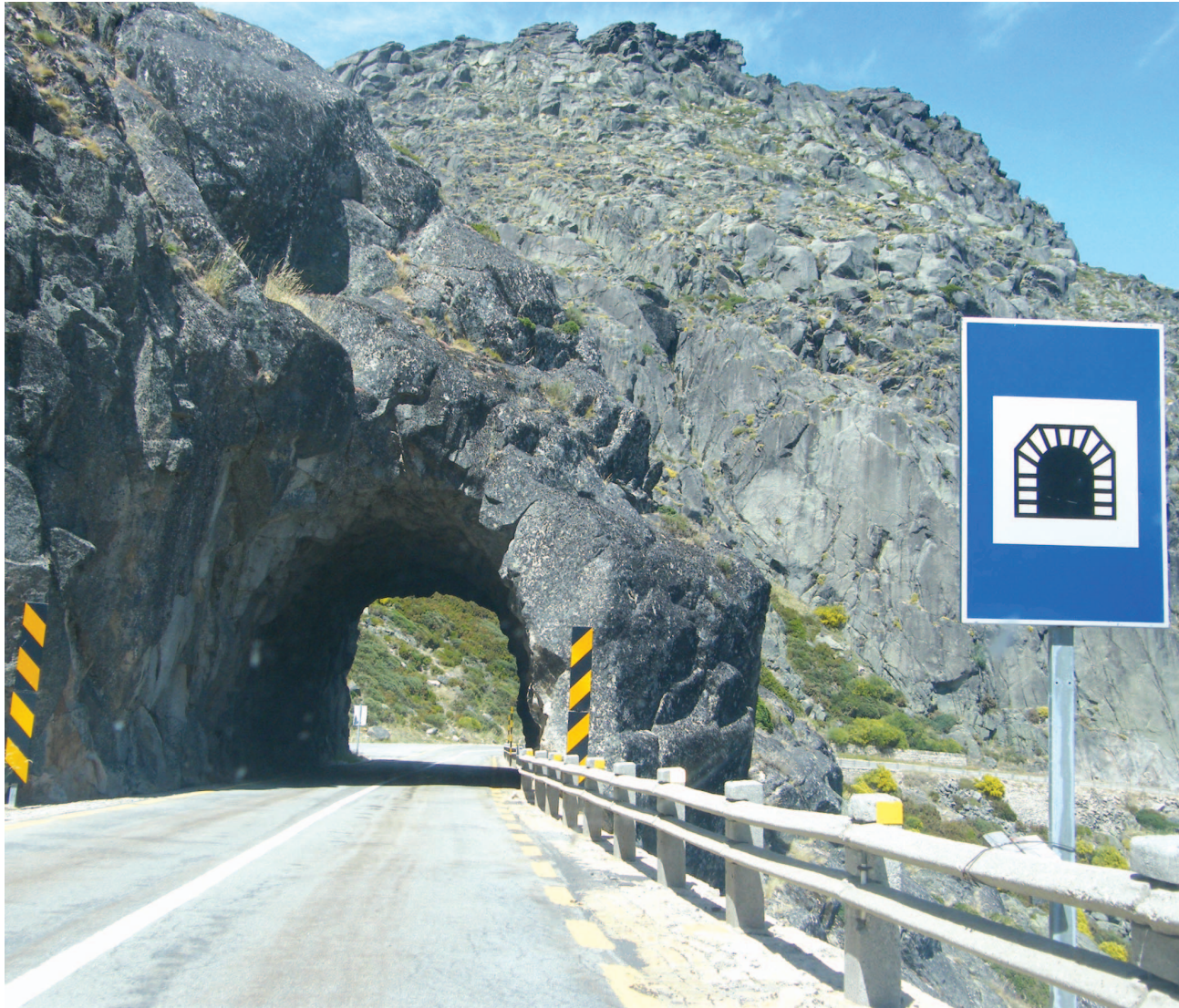
Trabalhos, que se iniciam a 4 de Maio, irão durar cerca de quatro meses
