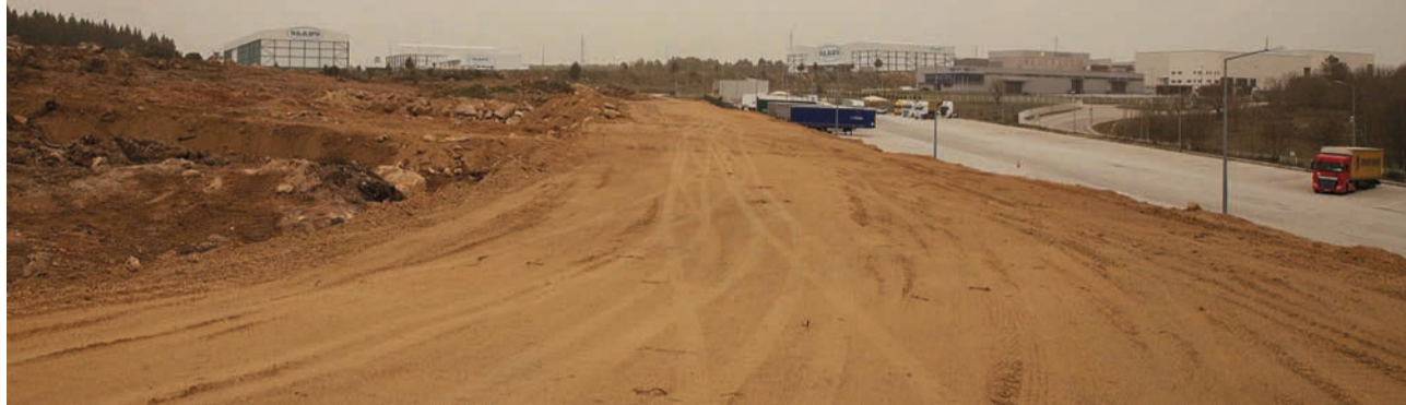
A intervenção inclui, entre outras ações, o movimento de terras, a execução de redes de drenagem de águas residuais pluviais e domésticas, infraestruturas de eletricidade, de telecomunicações e de gás, arruamentos e arranjos exteriores
