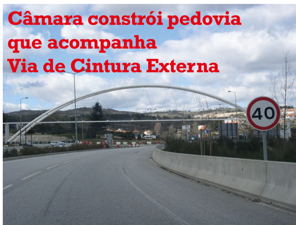
Obra, de um milhão de euros, aproveita traçado da VICEG entre as Lameirinhas e Parque Industrial
