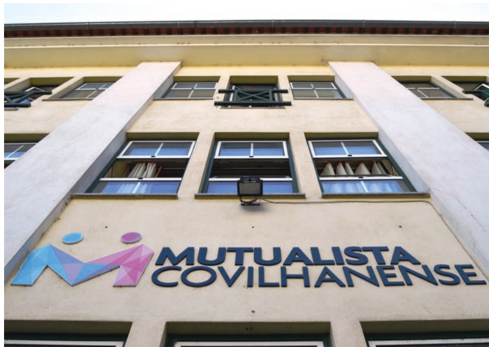
Edifício-sede, outrora uma fábrica têxtil, é um edifício antigo e por isso construído com “soluções pouco eficientes” recorda o presidente da Mutualista, Nelson Silva
