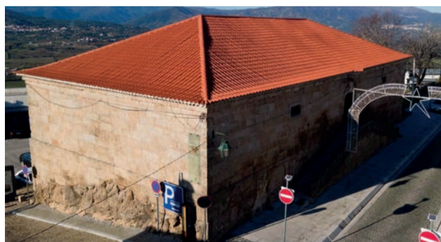
Requalificação do museu, nomeadamente da cobertura, custou cerca de 140 mil euros
