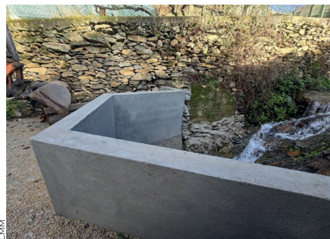
Estrutura de betão substituiu manilhas para maior vazão do canal
