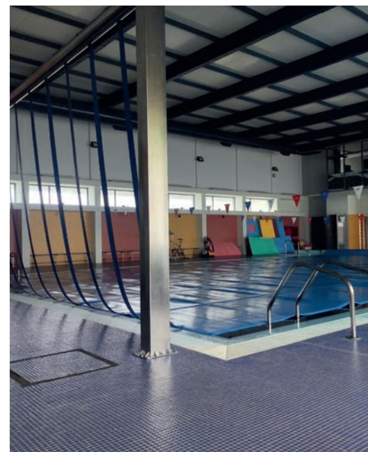
Segundo a AMCB, coberturas permitirão poupança de 400 mil euros em luz e gás
