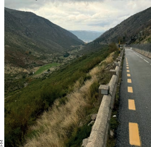
Colocação de barreiras dinâmicas na estrada 338 começa em abril
