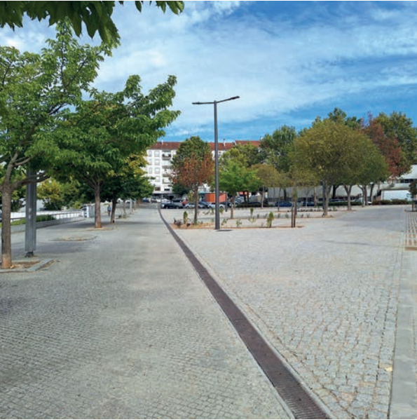
Segunda fase da obra implica criação de soluções inteligentes, como por exemplo, o estacionamento
